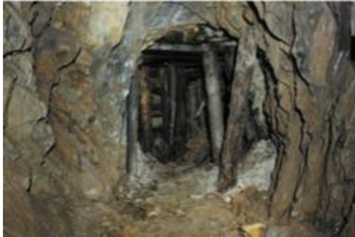
Une galerie de mine à l'étalement incertain
